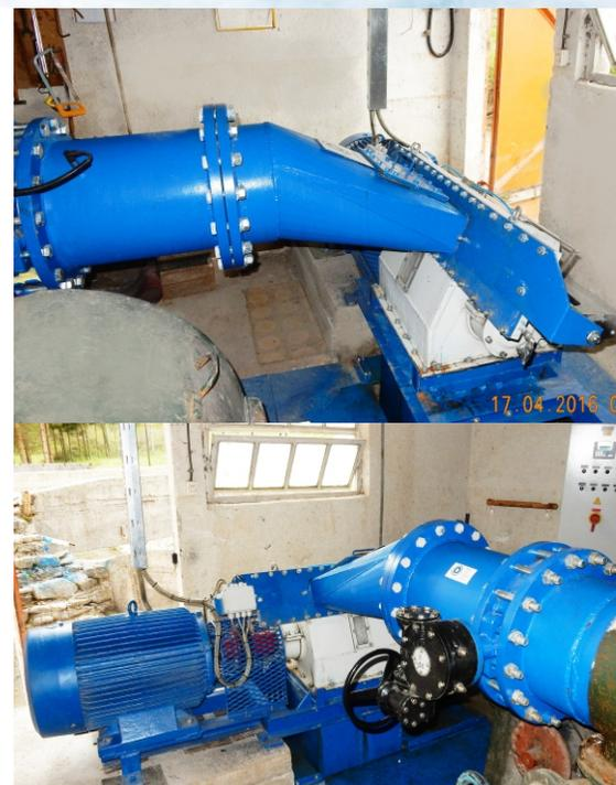
La turbina de flujo transversal de Siapro, mejorada con un sistema de regulación patentado para una competitiva alta eficiencia, está diseñada para siguientes condiciones:
